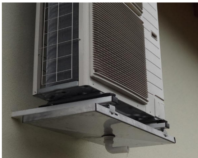
Fot. Taca na kondensat z podłączonym fragmentem syfonu.
