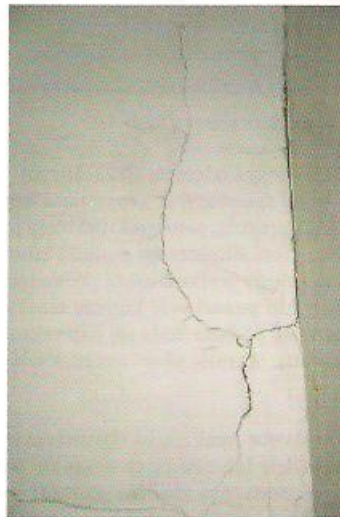
Rys. 23.3. Pęknięcia na powierzchni podłoża
