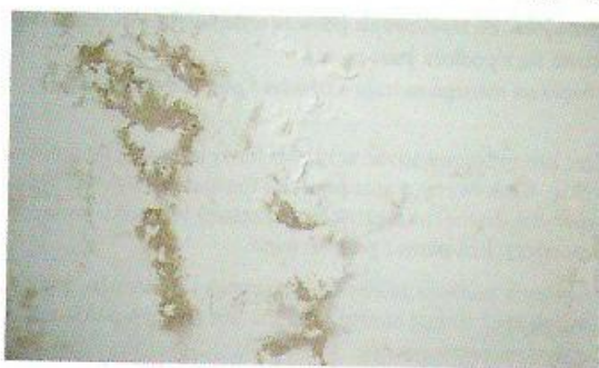
Rys. 23.4. Plamy i pęcherze na powierzchni podłoża
