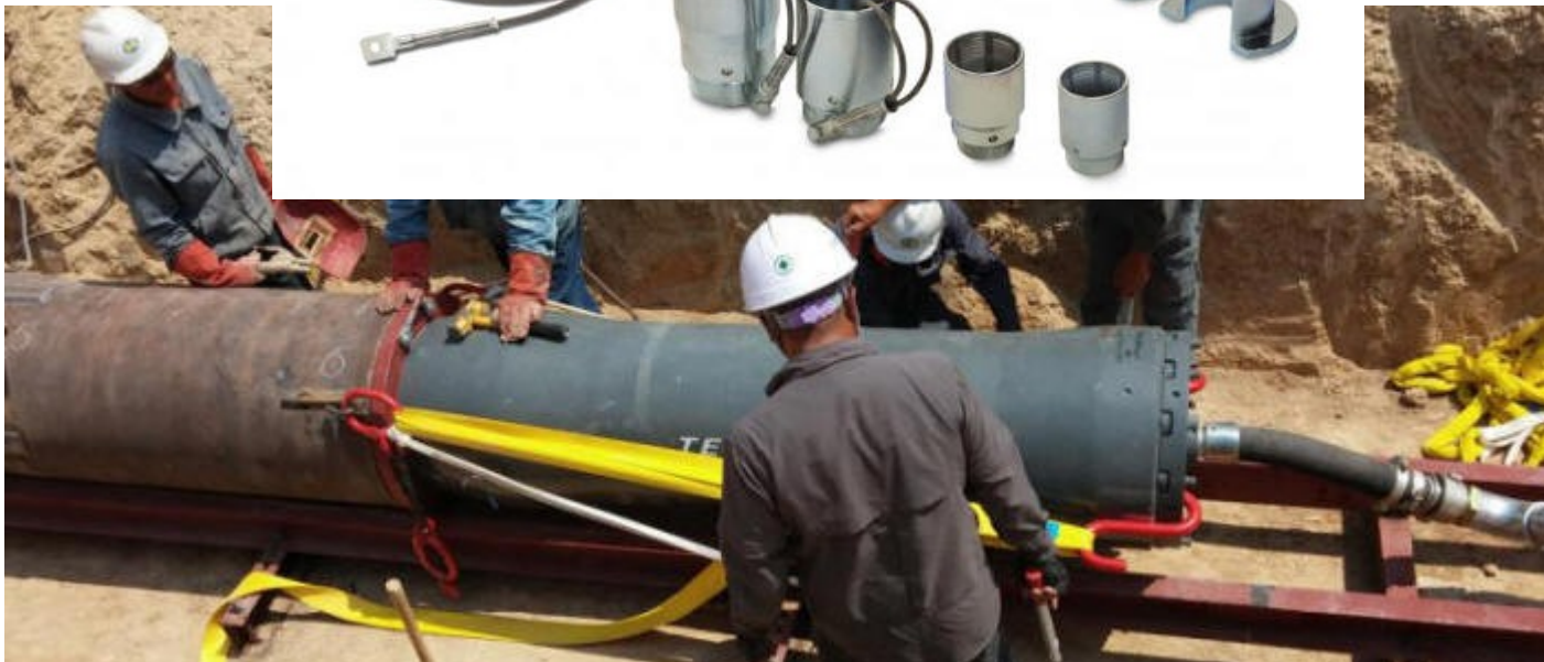
Fot. Przepisk z bijakiem umieszczonym za rurą stalową. (fot. Terra)
