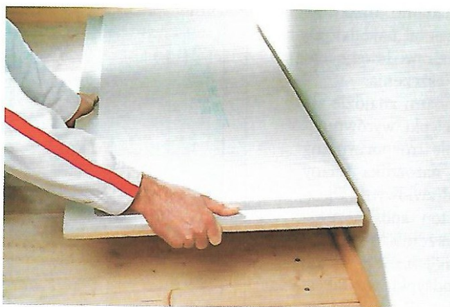
Rys. 7.7. Ułożenie pierwszej płyty suchego jastrychu
