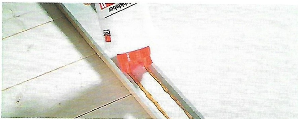
Rys. 7.9. Nałożenie kleju na zakład płyty
