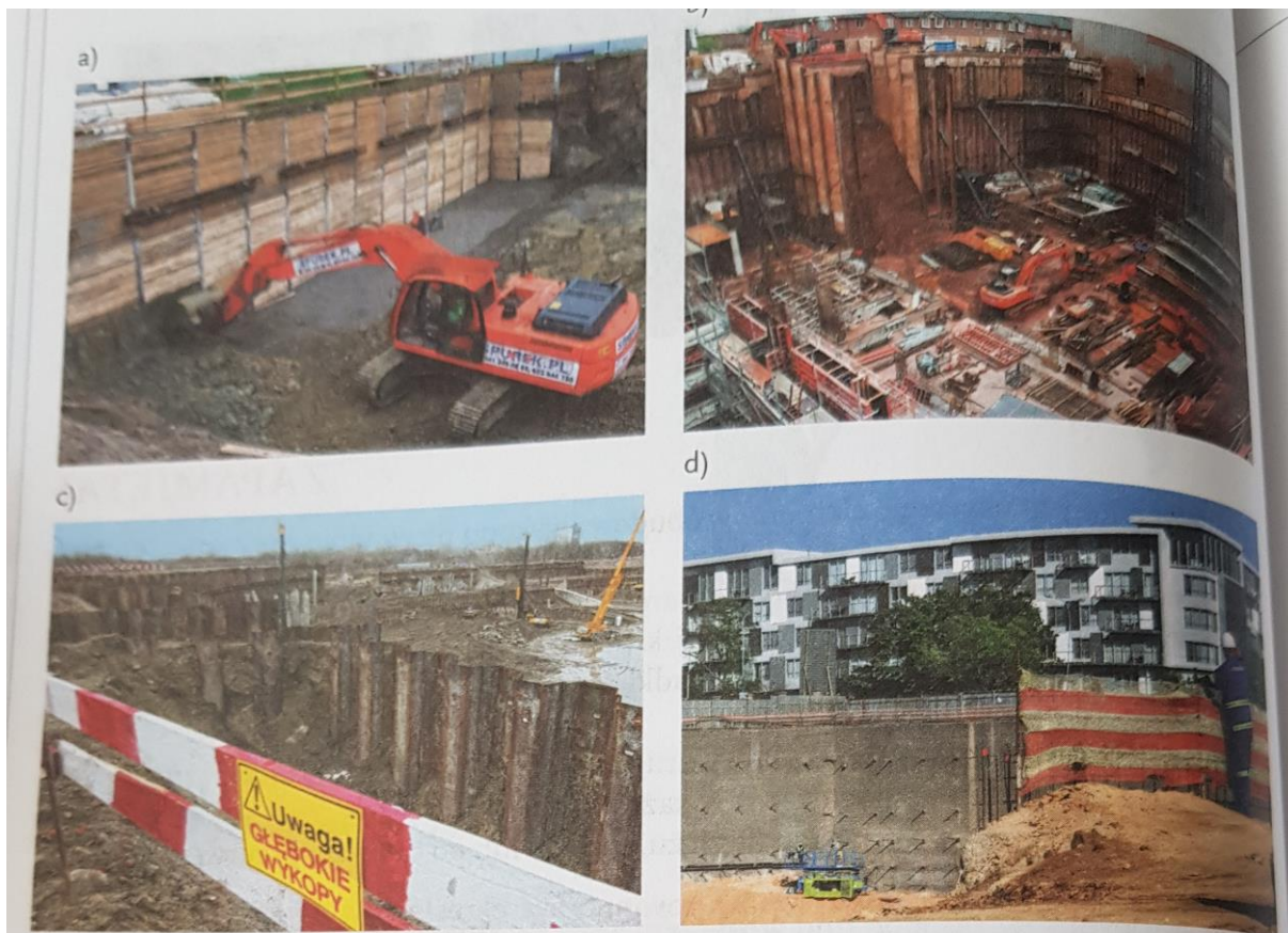
Rys. 3.32. Zabezpieczenie ścian wykopów szerokoprzestrzennych: a) ściankami berlińskimi, b) palisadami, c) grodzicami stalowymi, d) ścianami szczelinowymi
