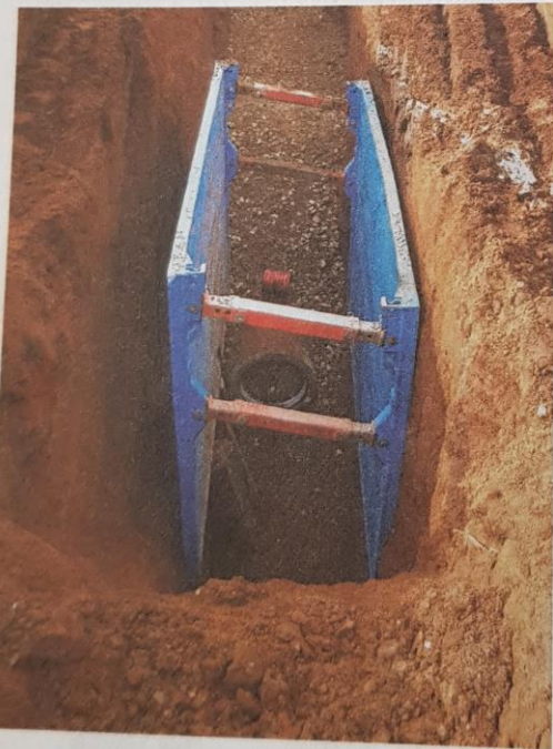
rys. 3.26. Przykład obudowy do zabezpieczania wykopów wąskoprzestrzennych
