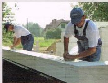
Fot. V. Po wymurowaniu pierwszej warstwy górną powierzchnię bloczków należy przeszlifować pacą do szlifowania SOLBET. W ten sposób eliminuje się ewentualne drobne nierówności. Po przeszliфовaniu powierzchni bloczków należy starannie oczyścić z pyłu. Zaprawę cienkowarstwową nanosi się za pomocą kielni SOLBET. Można ją nałożyć od razu na kilka bloczków. Trzeba jednak obserwować, czy pod wpływem wysokiej temperatury nie zacznie ona twardnieć zanim wymuruje się na niej bloczek.
