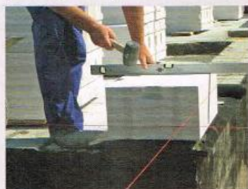
Fot. I. Prace rozpoczynają się od wymurowania bloczków w narożnikach budynku, ustawiając je w taki sposób, aby pióra bloczka znajdowały się na zewnątrz. Należy pamiętać, że w narożach łączą się bloczki prostopadłe, co oznacza, że nie będzie pomiędzy nimi połączenia w spoinie pionowej na pióra i wpusty. W związku z tym należy wypełnić zaprawą miejsca łączenia tych bloczków.
