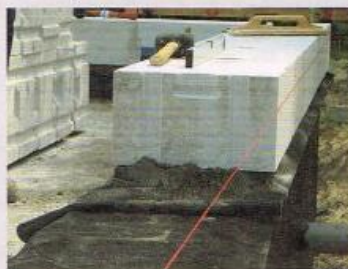
Fot. II. Ustawienie każdego bloczka korygujemy, delikatnie uderzając go młotkiem z gumowym obuchem. Po dokładnym wypoziomowaniu bloczków w narożniku rozciąga się między nimi sznur, wzdłuż którego muruje się kolejne bloczki.
