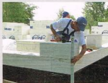
Fot. VI. Murowanie kolejnych warstw również zaczyna się od narożników. Bloczki, które nie zostały docięte, a więc mają pióra i wpusty, muruje się jedynie na spoinę poziomą. Bloczki w kolejnych warstwach także muruje się „pod sznur murarski” rozciągnięty między narożnikami. Po ustawieniu każdego bloczka, należy go dokładnie wypoziomować, korygując jego położenie młotkiem z gumowym obuchem i poziomnicą. W analogiczny sposób buduje się kolejne warstwy ściany.
