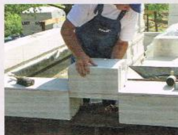
Fot. IV. Bloczki, których spoiny pionowe nie będą się łączyć na pióra i wpusty muszą być połączone za pomocą zaprawy. Na dociętą powierzchnię boczną bloczka należy więc nanieść zaprawę cienkowarstwową używając w tym celu kielni SOLBET o szerokości dostosowanej do szerokości bloczka. Dzięki niej warstwa zaprawy nie będzie grubsza, niż jest to wymagane. Docięty bloczek ustawia się na zaprawie cementowej.
