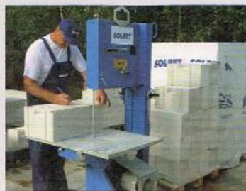
Fot. III. Ostatni bloczek w warstwie zawsze wymaga docięcia na odpowiedni wymiar. W tym celu na jego powierzchni należy zaznaczyć linię cięcia i dociąć element piłą taśmową lub ręczną piłą wędlową.
