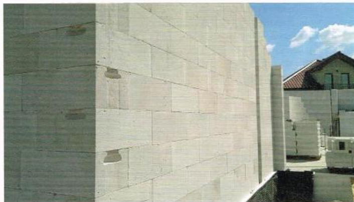
Prawidłowe przewiązanie wymurowanej ściany
