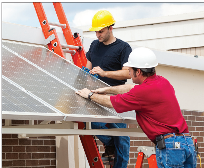
Montaż instalacji fotowoltaicznej na dachu domu jednorodzinnego
