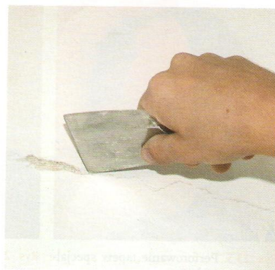
Rys. 23.8. Poszerzanie pęknięć podłoża
