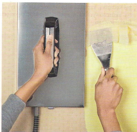
Rys. 23.6. Zwilżanie tapety parą wodną i usuwanie jej szpachelką
