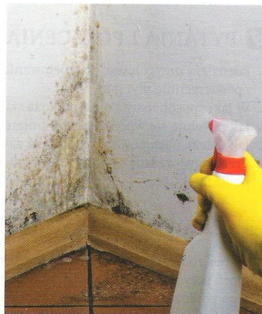
Rys. 23.10. Neutralizacja pleśni środkiem grzybobójczym
