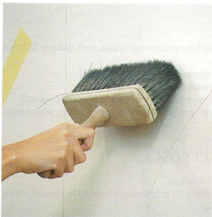
Rys. 23.9. Odkurzanie podłoża za pomocą pędzla
