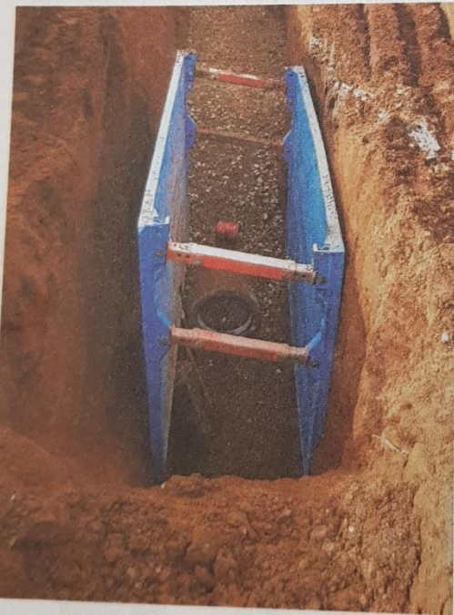
rys. 3.26. Przykład obudowy do zabezpieczenia wykopów wąskoprzestrzennych
