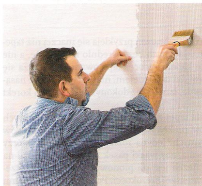
Rys. 24.27. Nakładanie kleju na ścianę za pomocą pędzla
