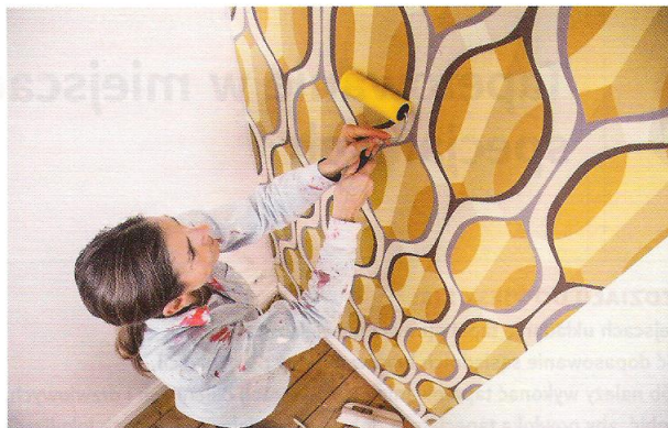
Rys. 24.30. Dociskanie tapety do ściany za pomocą gumowego wałka
