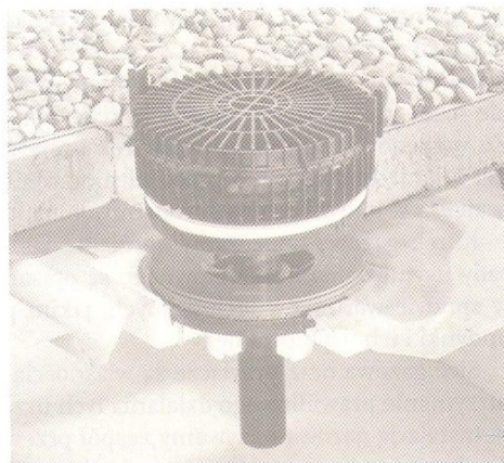
Rys. 1.56. Wpust dachowy stosowany w systemie Geberit Pluvia
