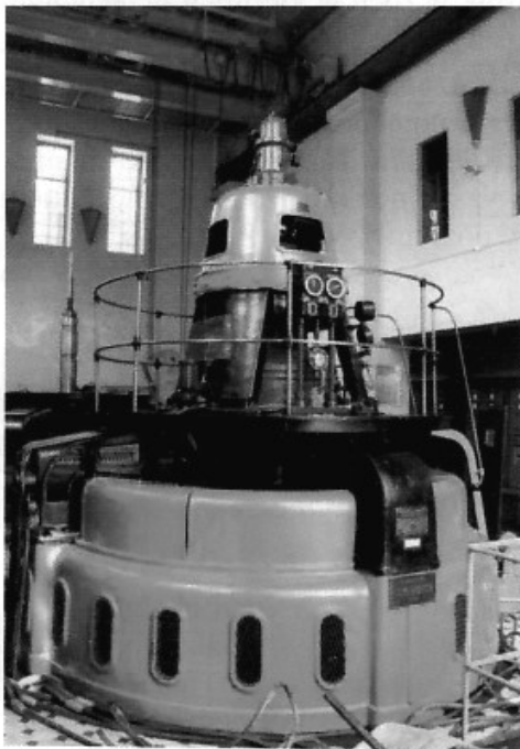
Rys. 381. Widok i przekrój turbiny Kaplana, wraz z prądnicą synchroniczną [304]
