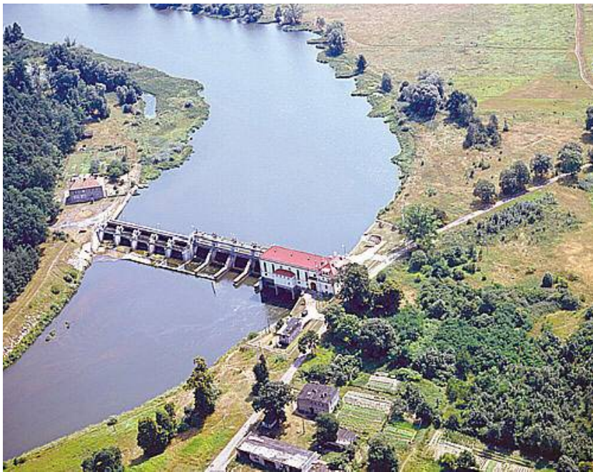
Fot. Elektrownia przepływowa Grajówka w pobliżu Gryżyc o mocy zainstalowanej 2972 kW.
