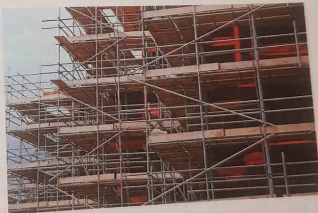
rys. 3.36. Przykład rusztowania ramowego i rurowego
