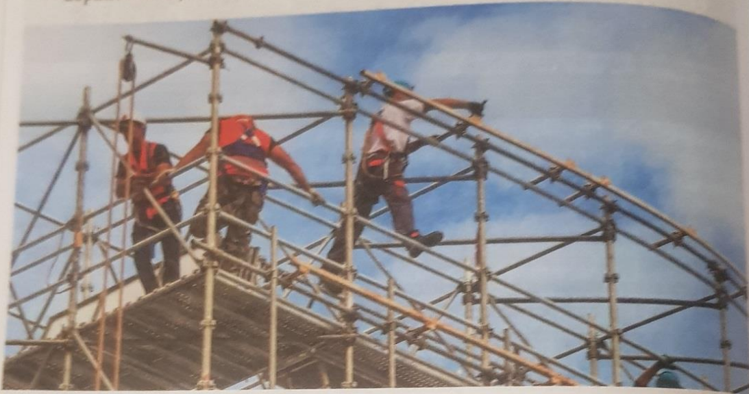
Rys. 3.39. Zabezpieczenie pracownika podczas wykonywania prac na wysokości
