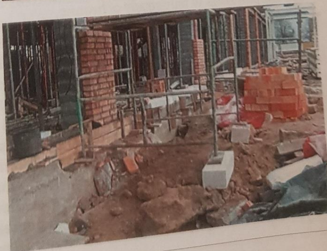
rys. 3.37. Nieprawidłowe posadowienie rusztowania (oparcie go na pustakach może prowadzić do podmycia i osiadania stojaków, a w przypadku uderzenia do rozkruszenia pustaków)
