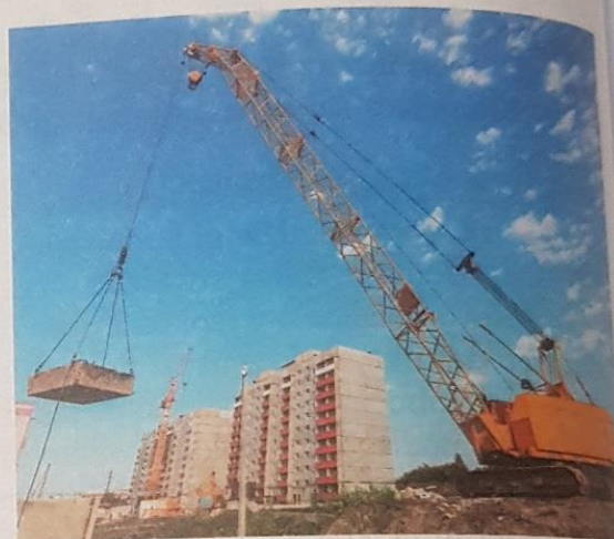
Rys. 3.9. Przenoszenie ładunku za pomocą żurawia samojezdnego
