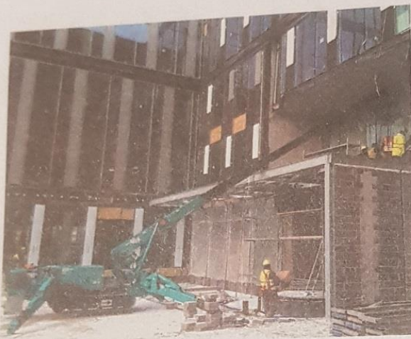
Rys. 3.8. Stosowanie przepisów bhp podczas transportu materiałów budowlanych
