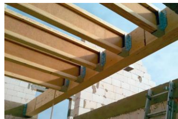
fragment konstrukcji z wiązarów (belek) dwuteowych
