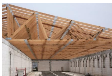
Drewniane konstrukcje kratownicowe
