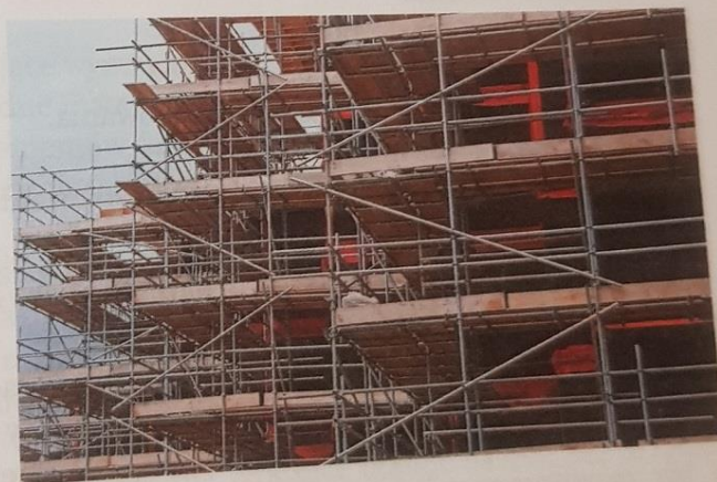
rys. 3.36. Przykład rusztowania ramowego i rurowego
