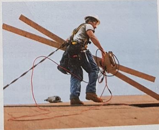
Rys. 4.22. Zastosowanie środków ochrony indywidualnej podczas prac na wysokości (montaż i demontaż rusztowań, prace dekarские)
