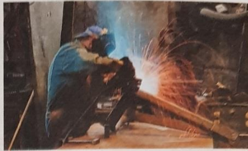
Rys. 4.24. Prace stwarzające zagrożenie pożarem
