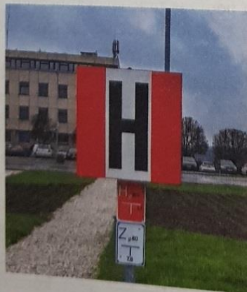
Rys. 4.28. Informacyjny znak odblaskowy ocynkowany 250 × 250 mm i hydrant przeciwpożarowy zewnętrzny
