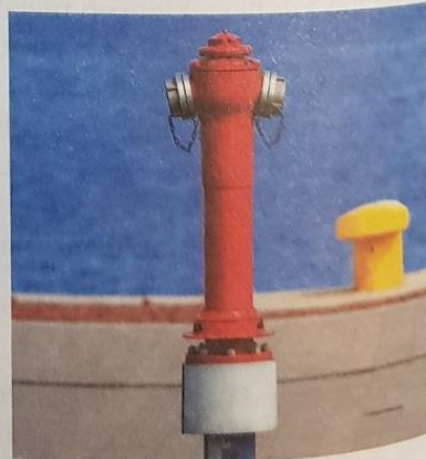
Rys. 4.28. Informacyjny znak odblaskowy ocynkowany 250 × 250 mm i hydrant przeciwpożarowy zewnętrzny
